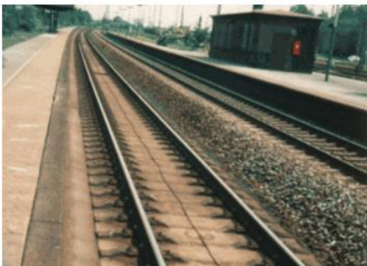
Slika 2.4. Rheda-Wiedenbrück željeznička stanica sa "Rheda" kolosiječnom konstrukcijom 8
