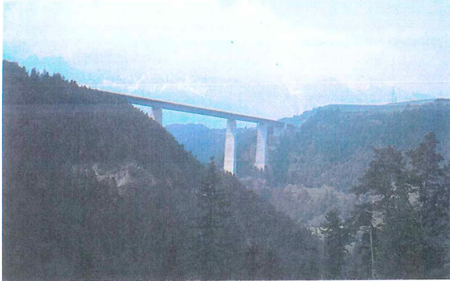
Slika 8. Primjer dobro izvedenog vijadukta Europa Brücke, Innsbruck, Austrija Izvor: Marinović-Uzelac, A. Prostorno planiranje, Dom i svijet, Zagreb, 2001., p.365
