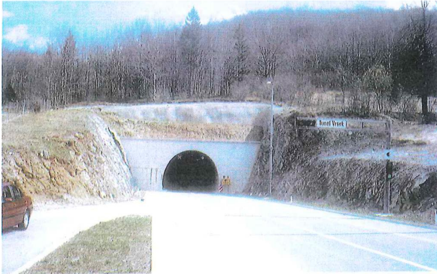
Slika 6. Primjer loše izgrađenog tunela u neskladu s krajolikom, poluautocesta Zagreb-Rijeka, Hrvatska Izvor: Marinović-Uzelac, A. Prostorno planiranje, Dom i svijet, Zagreb, 2001., p.367
