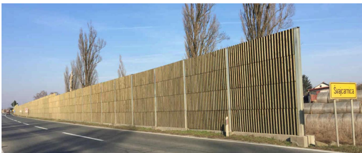
Slika 19. Primjer bukobrana izrađenog od drvenih panela, Švajcarnica-Osijek
