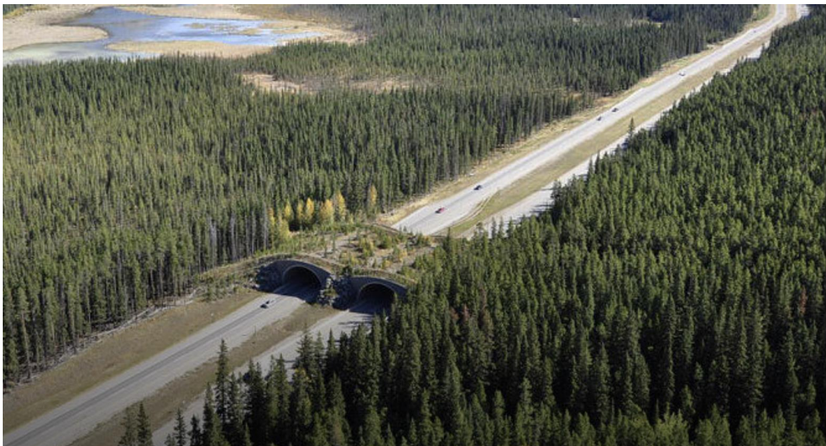
Slika 20. Zelena površina iznad tunela
