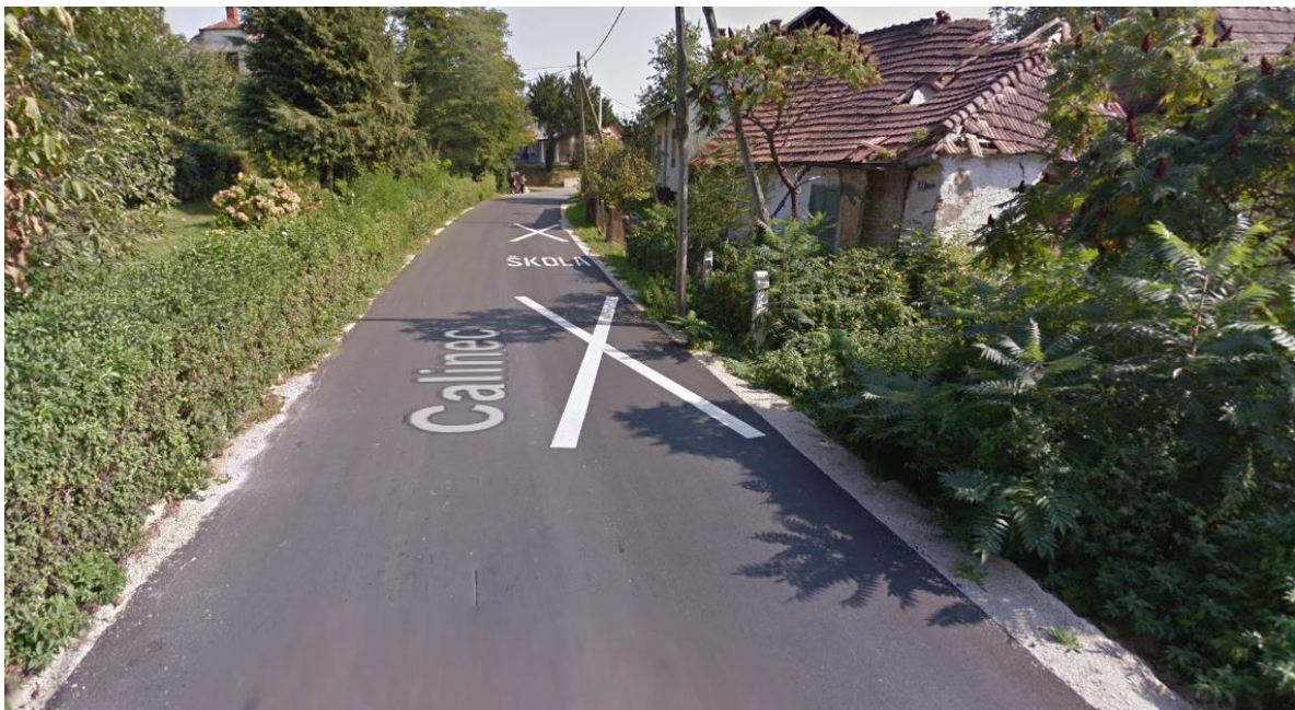
Slika 23. Nedostatak nogostupa i pješačkog prijelaza u blizini Osnovne škole Maruševec
