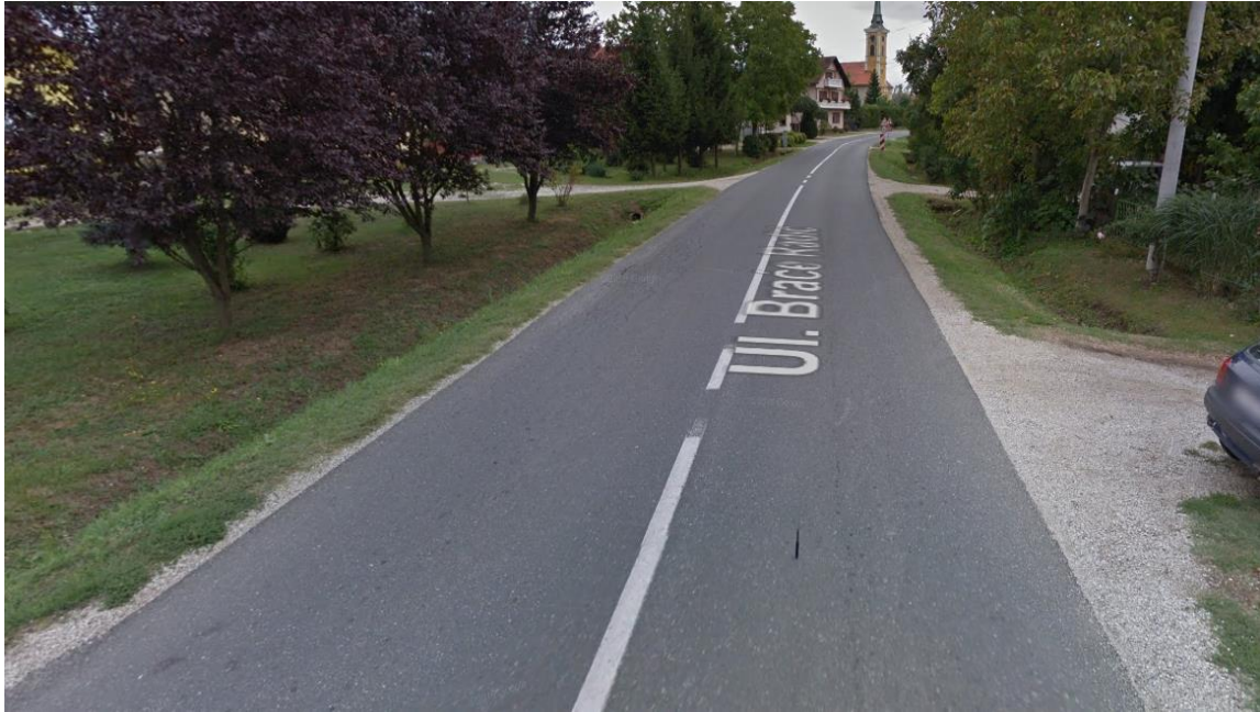
Slika 26. Nedostatak pješačke staze na županijskoj cesti Ž2071
