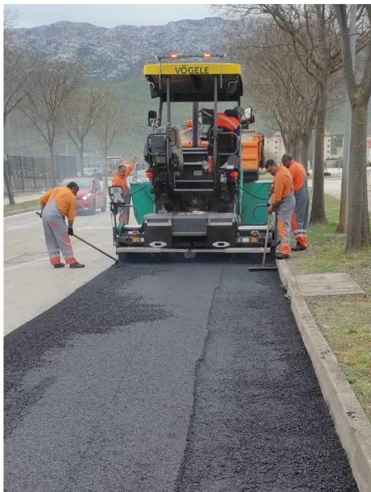
Slika 14: Radovi na krpanju cestovnog zastora
