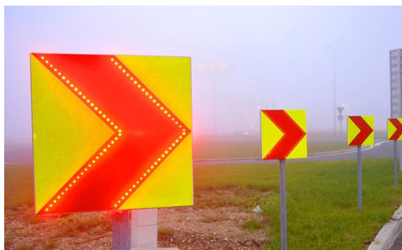
Slika 12. Prometni znak K-10 s ugrađenim svjetlosnim elementima, [16]
