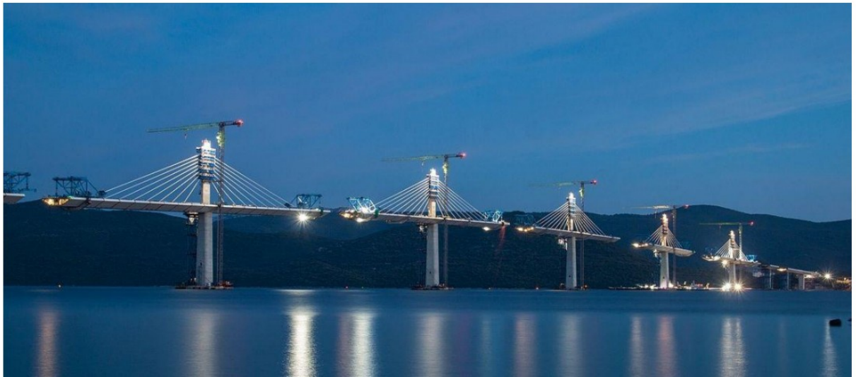
Slika 9. Spajanje Pelješkog mosta
