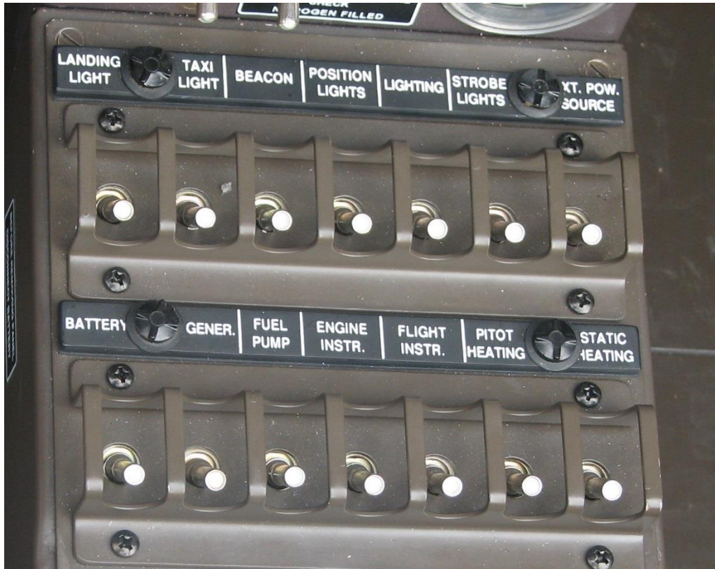
Slika 9. Prekidači s diferencijalnom strujnom zaštitom
