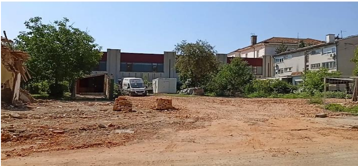
Slika 32. Zatečeno stanje objekta klasificiranog s manjim oštećenjima-2.primjer
