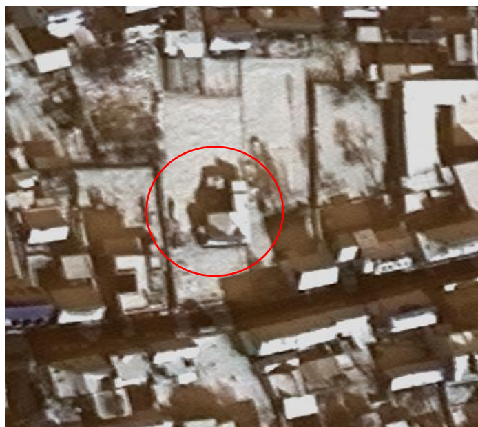
Slika 18. Oštećenje vidljivo iz sjene objekta
