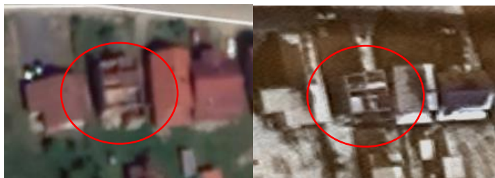
Slika 19. Objekt oštećen prije potresa
