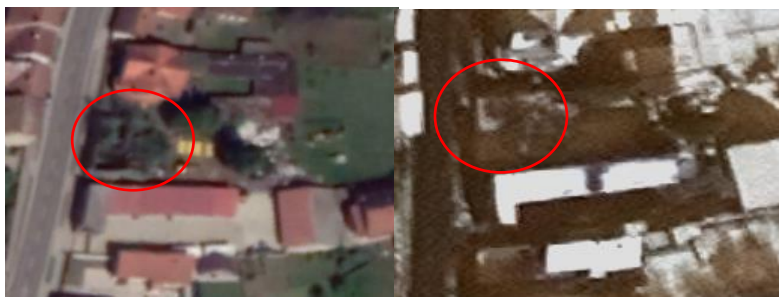
Slika 37. Objekt prikazan na snimkama prije i nakon potresa-5.primjer
