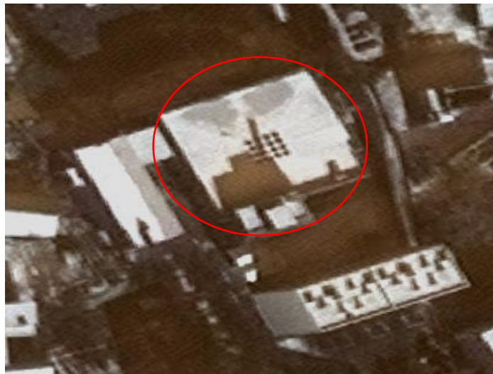
Slika 12. Objekt klase 1 oštećenja
