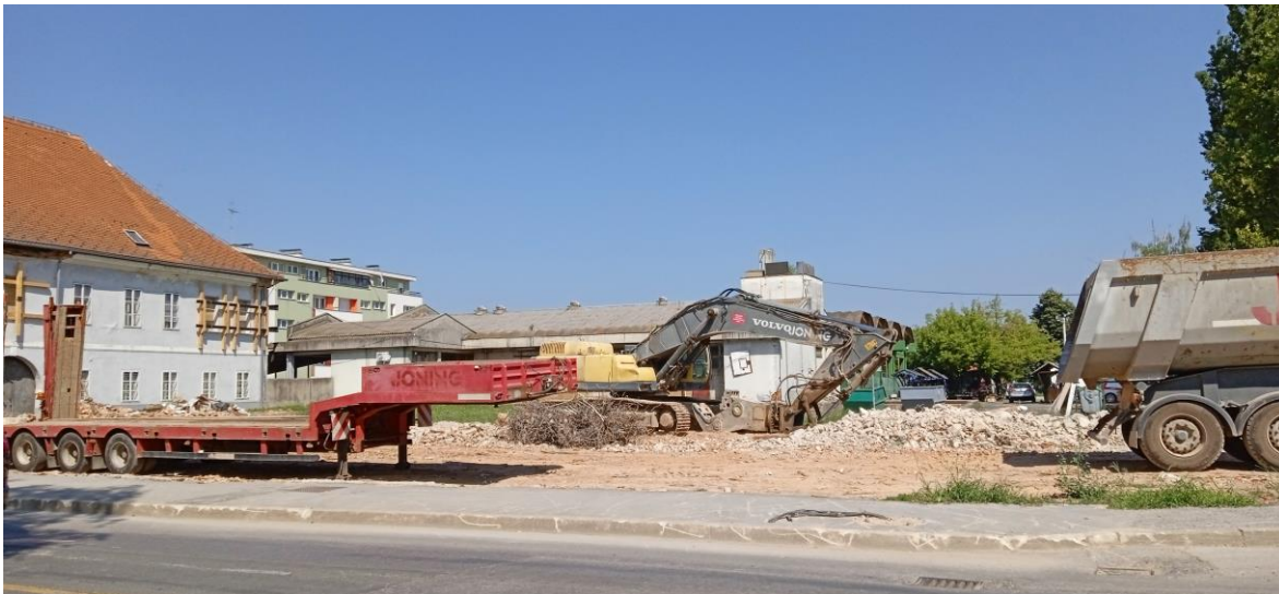
Slika 30. Zatečeno stanje objekta klasificiranog s manjim oštećenjima-1.primjer
