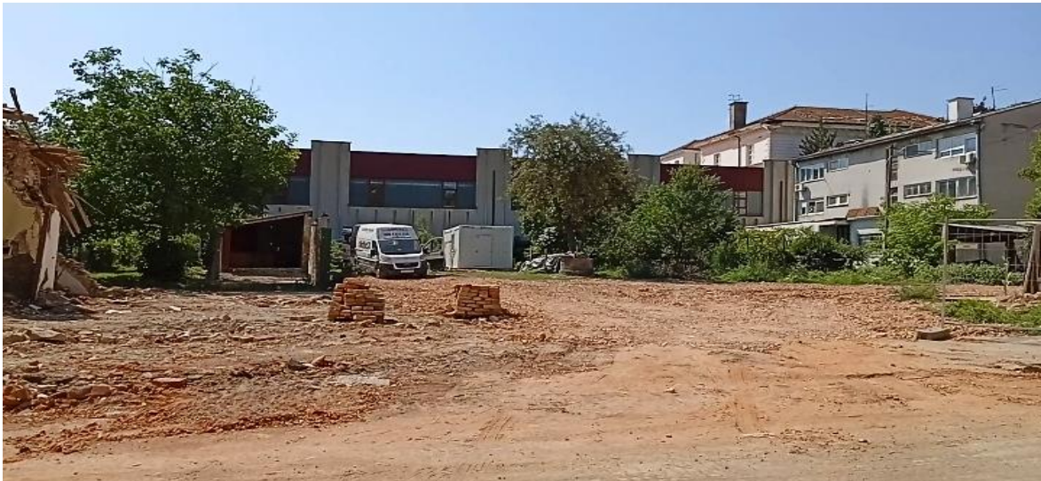
Slika 32. Zatečeno stanje objekta klasificiranog s manjim oštećenjima-2.primjer
