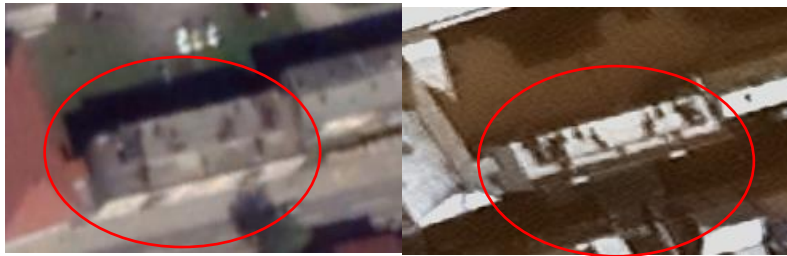
Slika 29. Objekt prikazan na snimkama prije i nakon potresa-1.primjer
