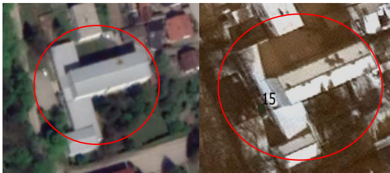
Slika 35. Objekt prikazan na snimkama prije i nakon potresa-4.primjer
