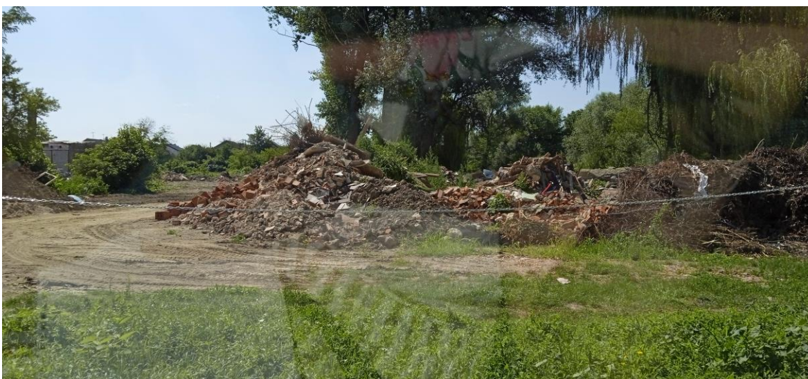
Slika 38. Zatečeno stanje objekta -5.primjer
