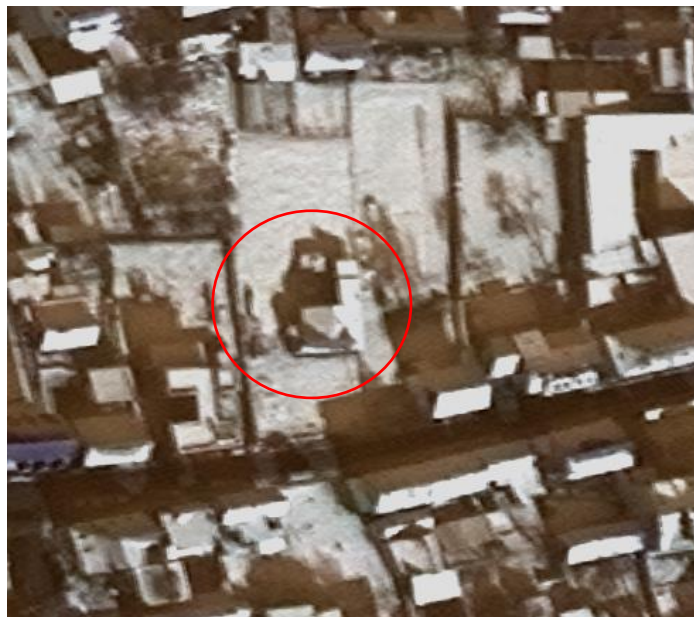
Slika 18. Oštećenje vidljivo iz sjene objekta
