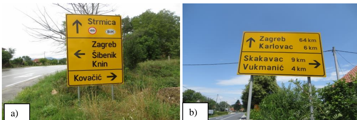
Slika 14. Primjeri znaka D07 na DC1 koji nije po Pravilniku (a) i koji je po Pravilniku (b)
