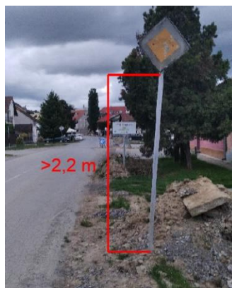
Slika 22. Primjer prometnog znaka na visini većoj od 2,2 metra
