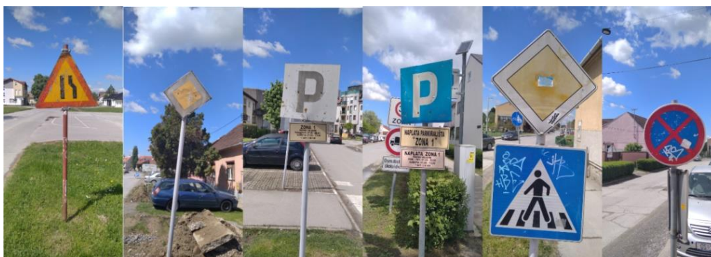
Slika 16. Primjeri oštećenih prometnih znakova
