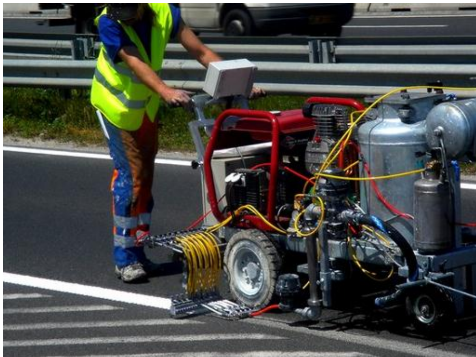
Slika 4. Postavljanje kolničkih oznaka od hladne plastike
