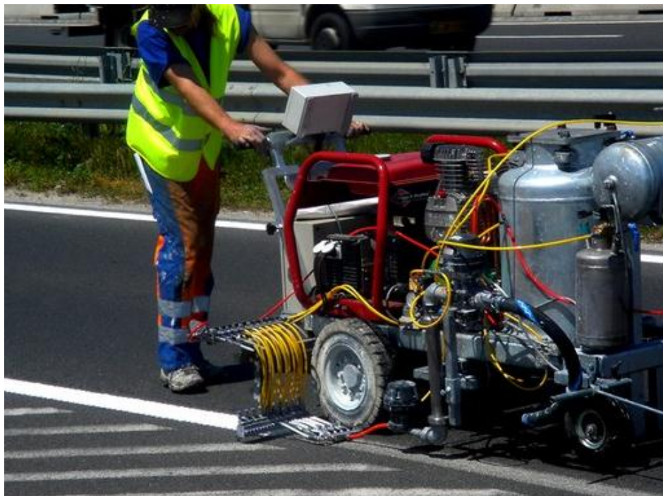
Slika 4. Postavljanje kolničkih oznaka od hladne plastike
