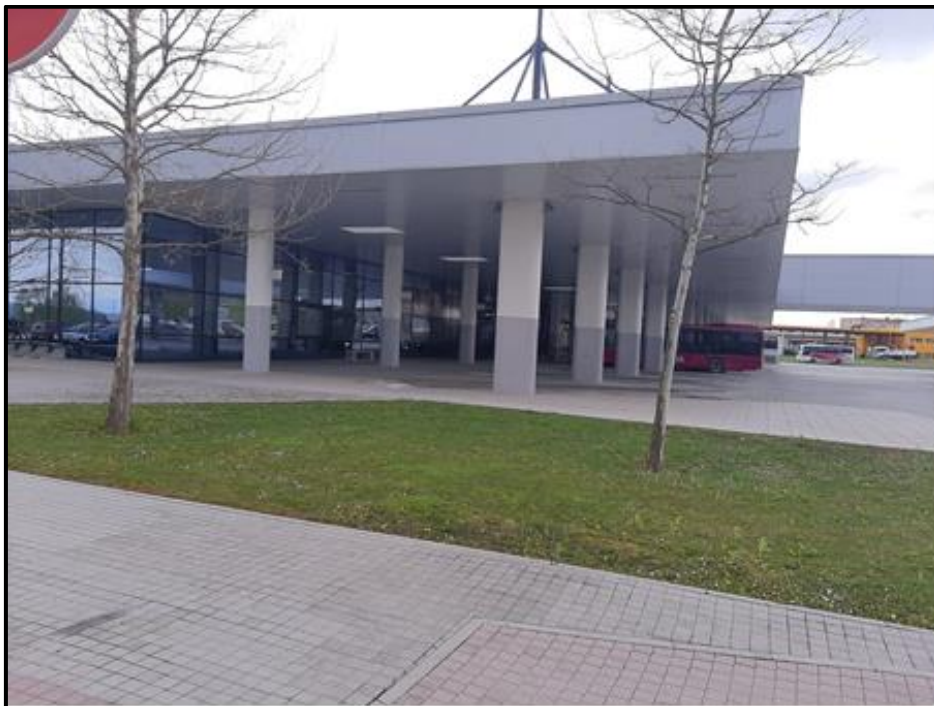
Slika 21. Postojeći autobusni kolodvor u Samoboru Izvor: autor
