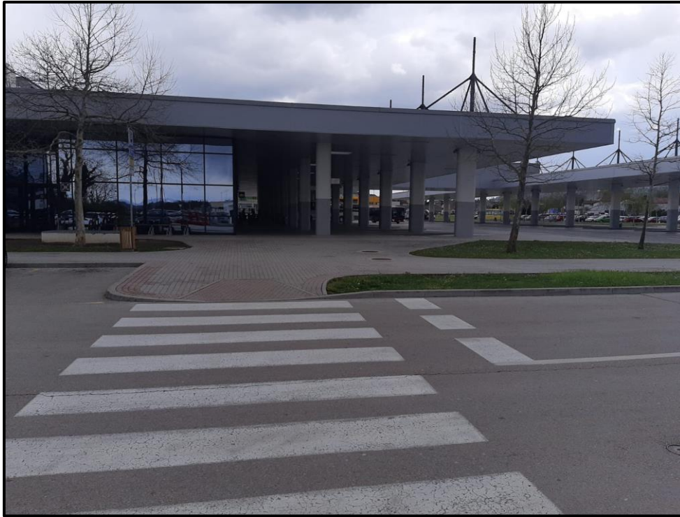
Slika 20. Postojeći autobusni kolodvor u Samoboru Izvor: autor
