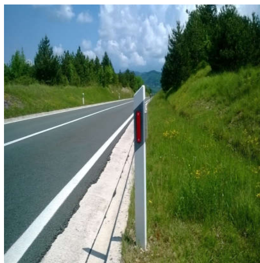
Slika 38. Optički senzor na smjerokaznom stupiću
