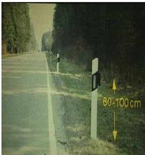
Slika 35. Visina postavljanja senzora na smjerokazni stupić
