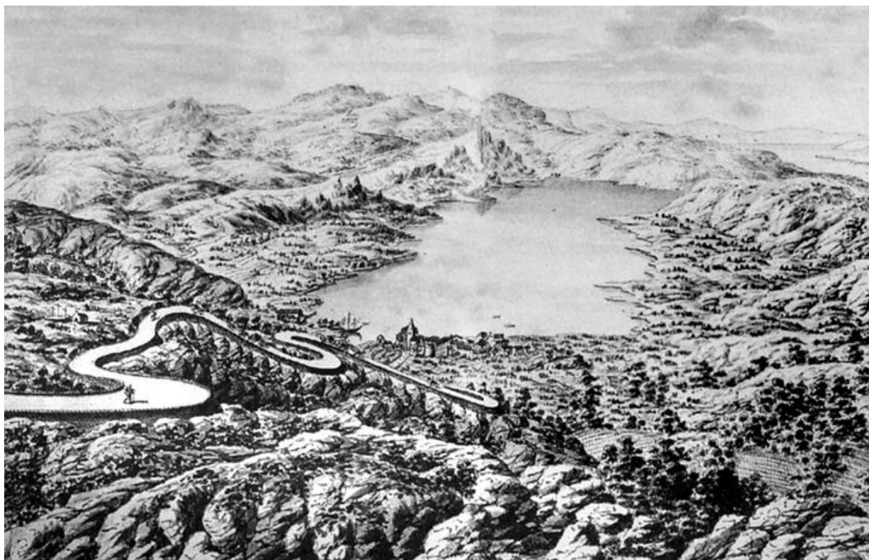
Slika 2. Spust Karolinske ceste prema Bakarskom zaljevu izgrađen 1726. godine Izvor: [4]
