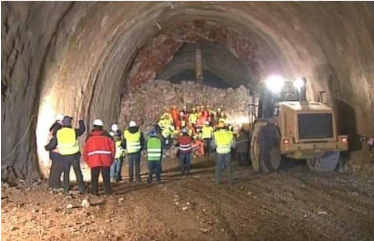
Slika 10. Probijen posljednji tunel na dionici Rijeka – Zagreb Izvor: [18]
