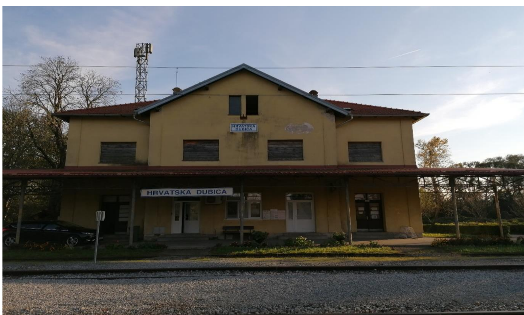
Slika 7. Kolodvorska zgrada kolodvora Hrvatska Dubica
