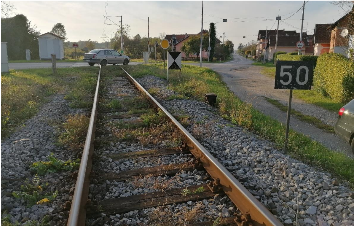
Slika 6. Žuti signalni lopar na mjestu predsignala ulaznog signala „A“ kolodvora Sunja i pogled sa pruge na ŽCP „Vedro Polje“
