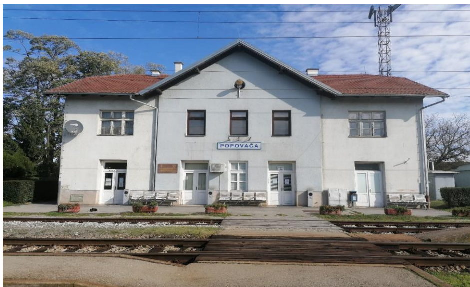
Slika 1. Kolodvorska zgrada kolodvora Popovača
