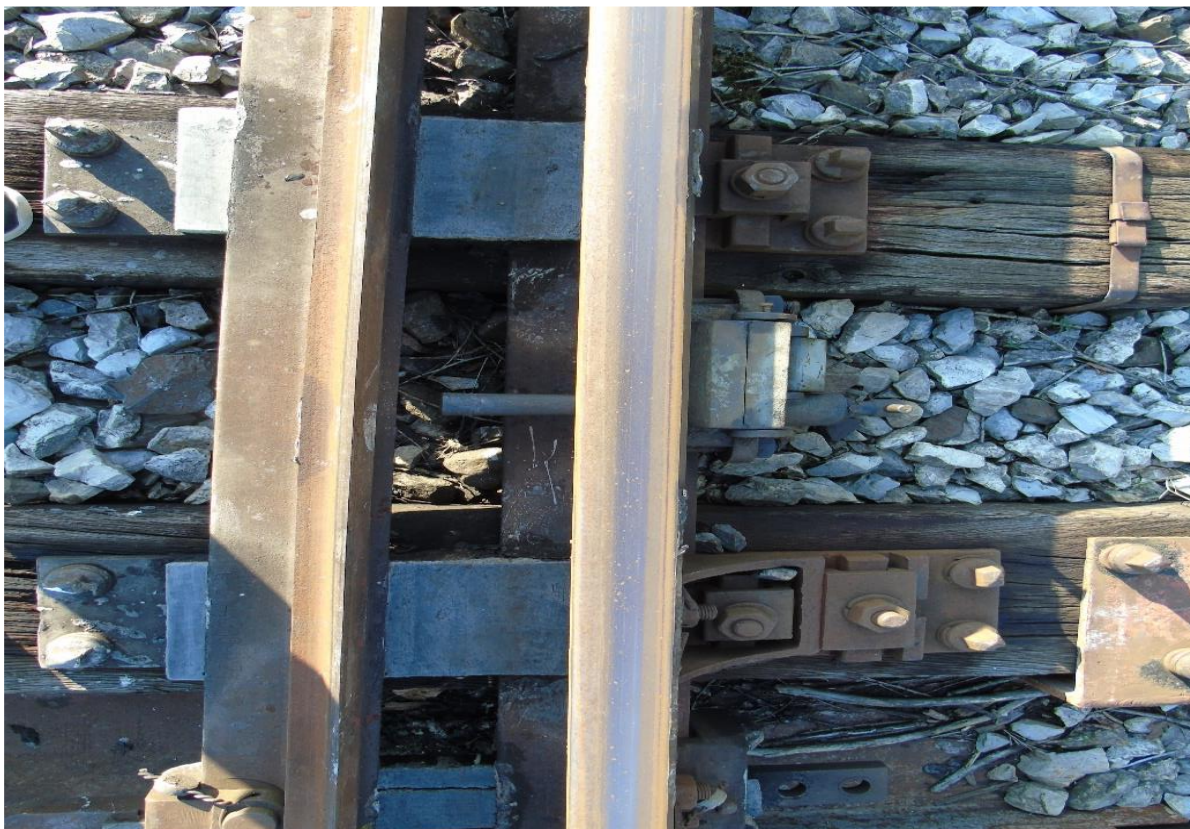
Slika 21. Skretnička brava tipa „Robel“ u zaključanom položaju u pravac
