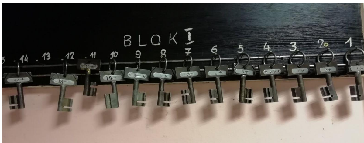
Slika 15. Ključevi skretnica od strane bloka 1
