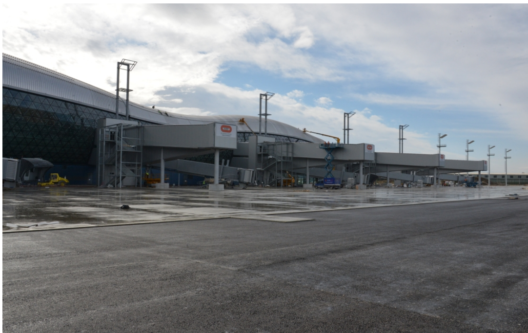
Slika 21. Zračni mostovi novog putničkog terminala, [38]
