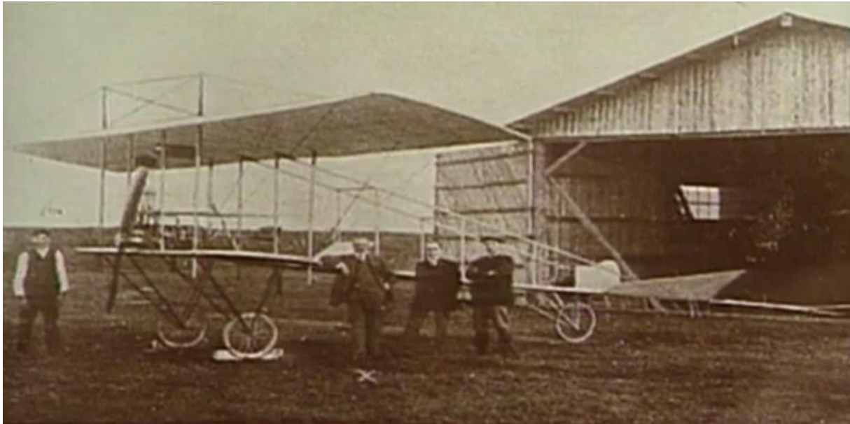
Slika 2. Penkalin hangar na Črnomercu, [3]
