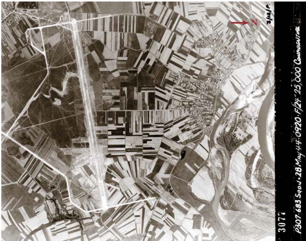
Slika 6. Prikaz dovršene betonske uzletno sletne staze aerodroma Pleso, [8]
