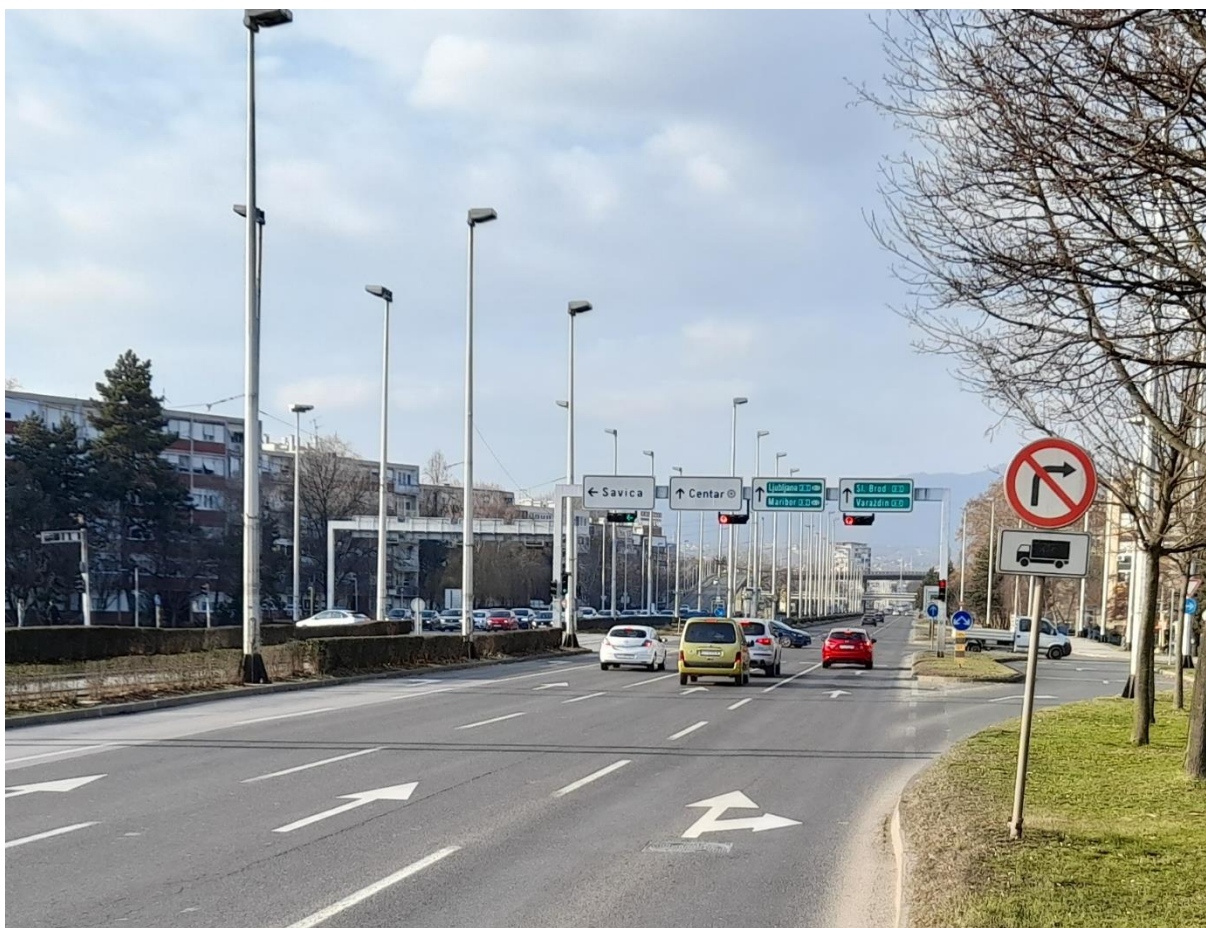
Slika 7. Prikaz južnog privoza raskrižja Av. M. Držiča - Ul. M. Trnine – Lastovska
