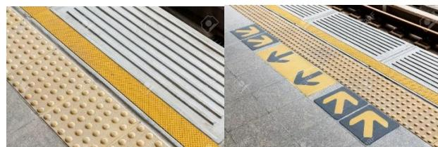
Slika 15. Taktilna površina na željezničkom peronu sa i bez strelica za usmjerenje, [32]
