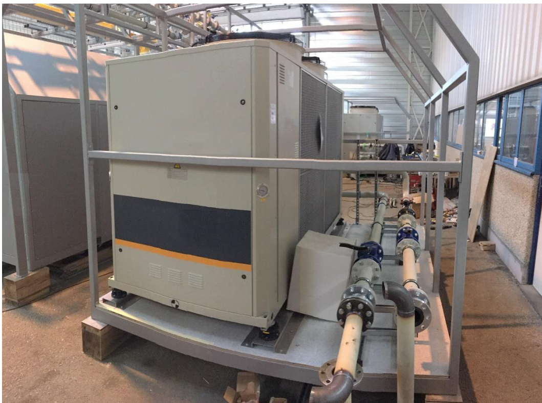
Slika 9. Ugradnja modula u okvir, [20]
