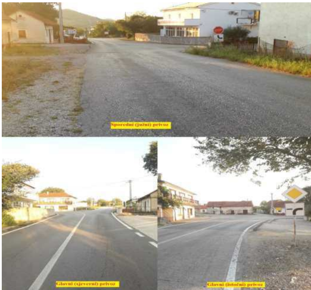
Slika 41. Pogled na privoze raskrižja 7
