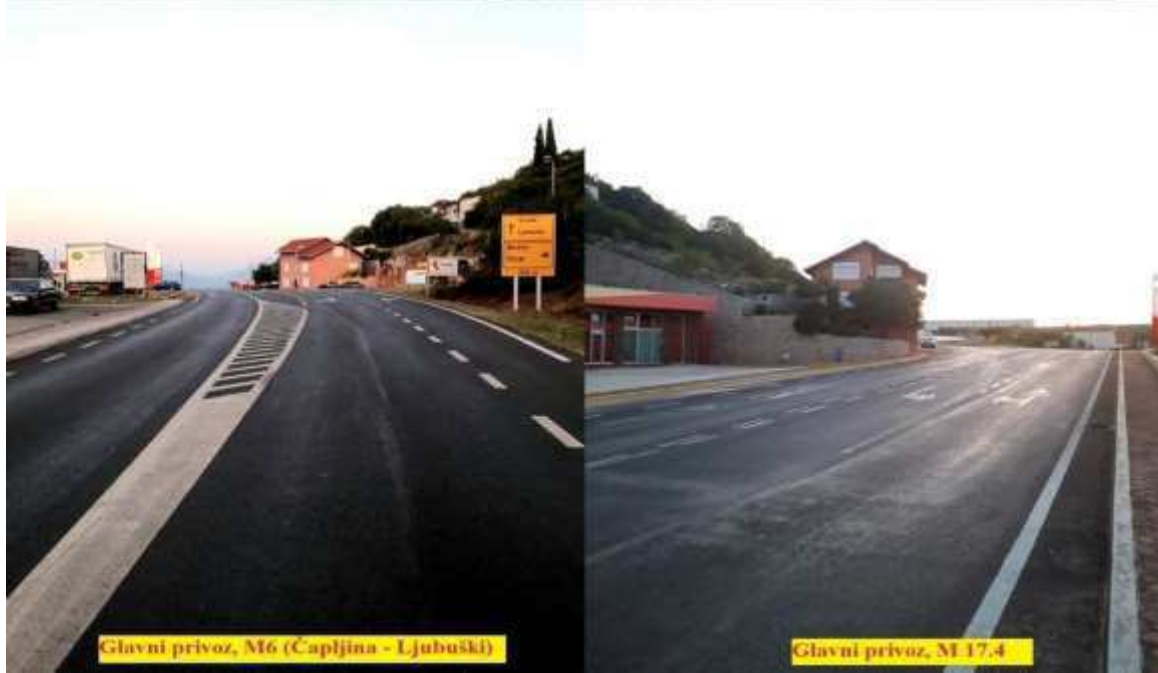
Slika 34. Pogled na privoze raskrižja 2
