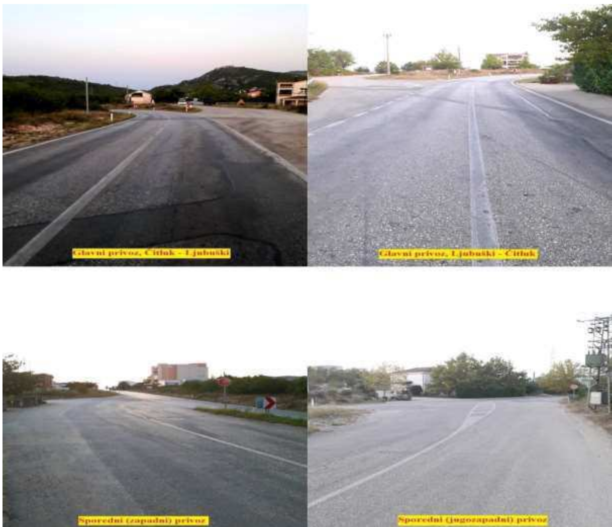
Slika 33. Pogled na privoze raskrižja 1
