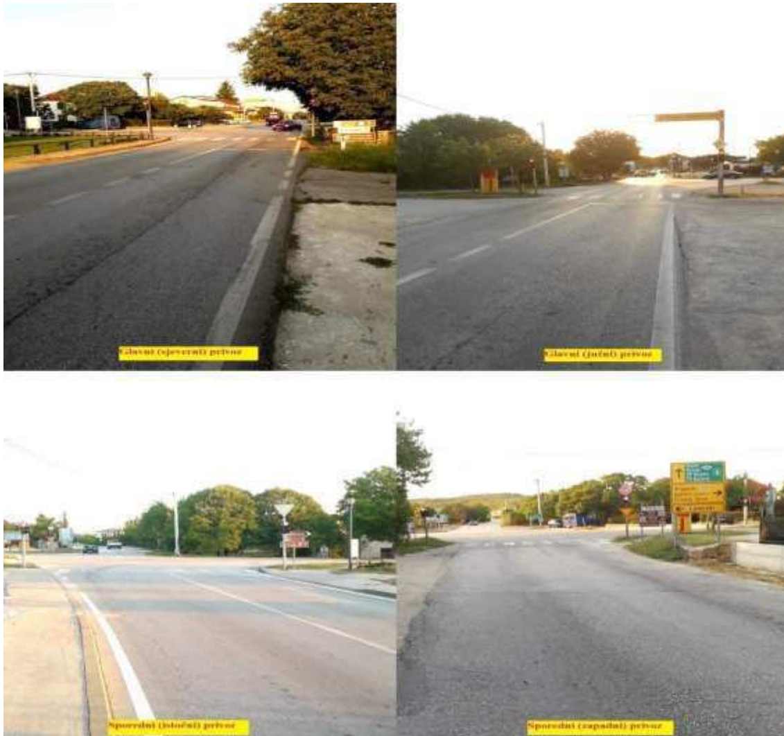
Slika 40. Pogled na privoze raskrižja 6
