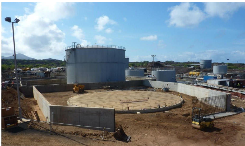
Slika 29. prikaz početka izgradnje spremnika te sabirnog prostora oko spremnika Izvor: [44]
