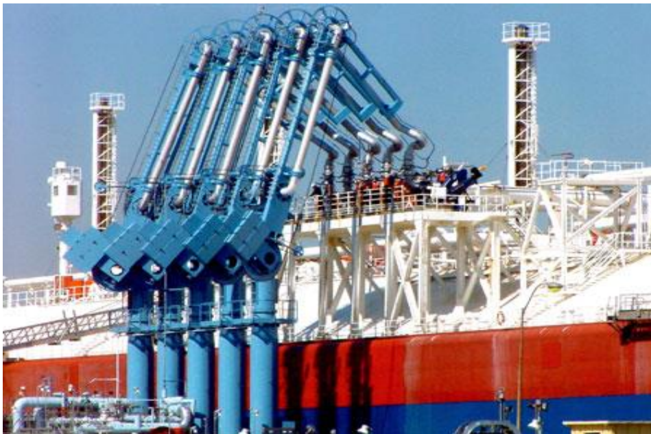
Slika 62. Prekrcaj tekuće rasute biomase sa pretakačkim rukama
