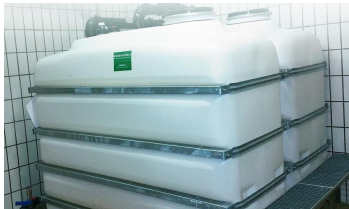
Slika 39. Specijalizirane kutije za skladištenje kruto rasute biomase
