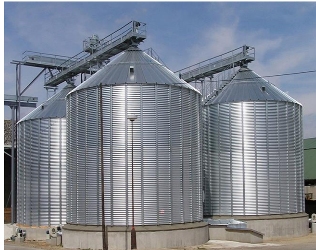
Slika 37. Silos sa ravnim dnom
