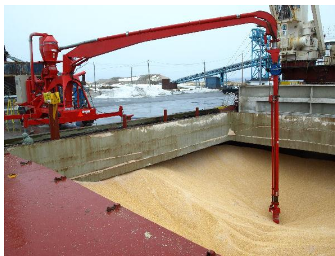
Slika 25. Brodski vakuumski iskrcavač
