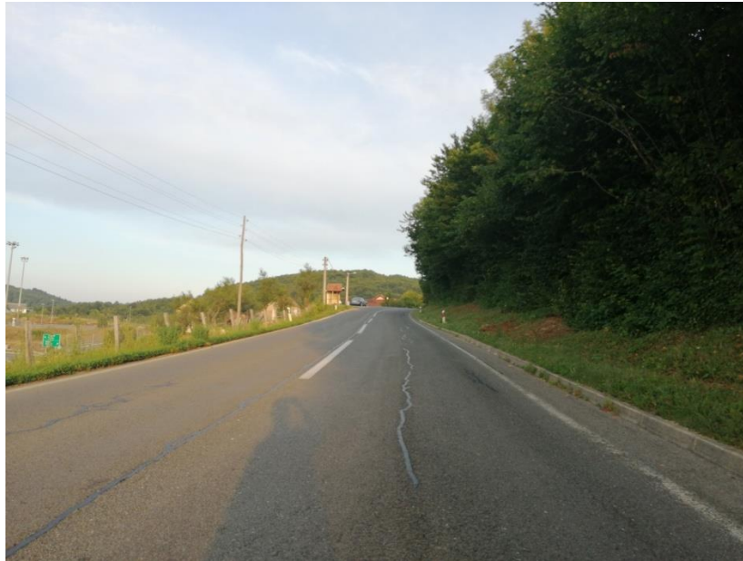
Slika 14: Prikaz dionice ceste iz smjera sjeverozapada
