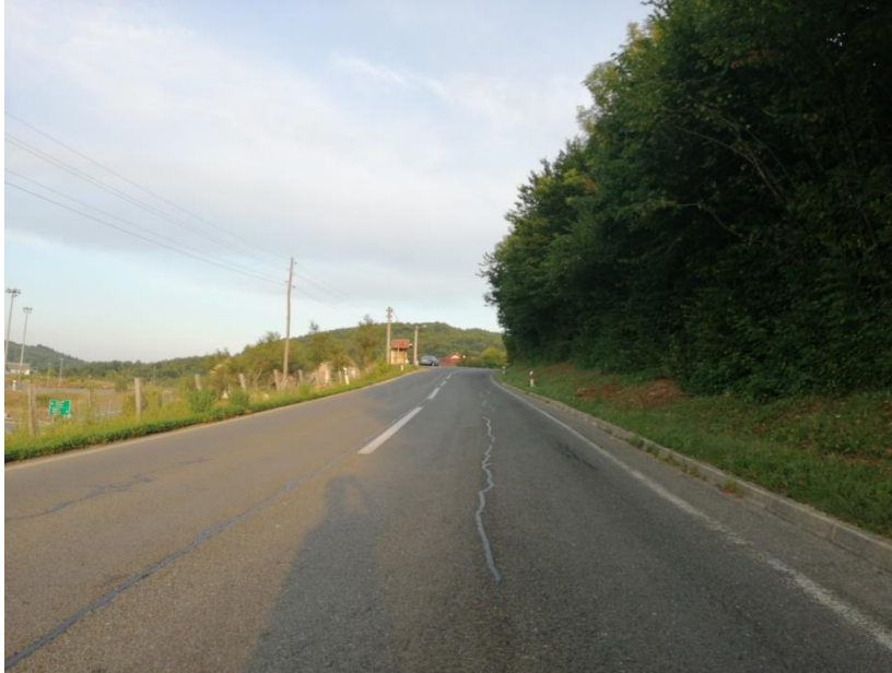
Slika 14: Prikaz dionice ceste iz smjera sjeverozapada
