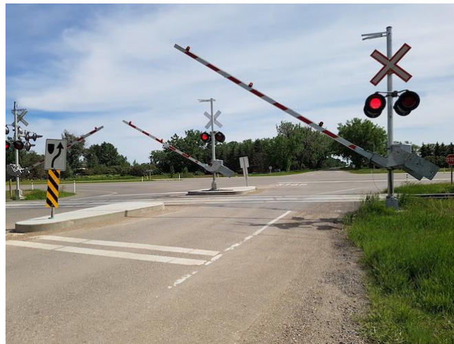
Slika 24. Fizičko odvajanje trakova ispred željezničko-cestovnog prijelaza s polubranicima [29]
