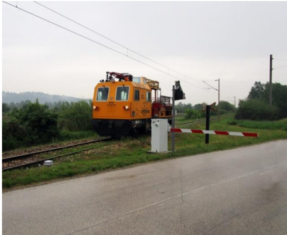
Slika 8. Željezničko cestovni prijelaz osiguran polubranikom [6]
