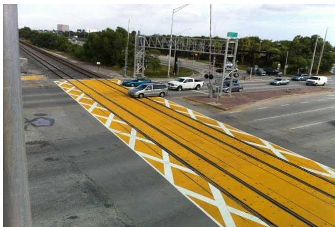
Slika 26. Obojene oznake na kolniku za označavanje opasne zone [30]
