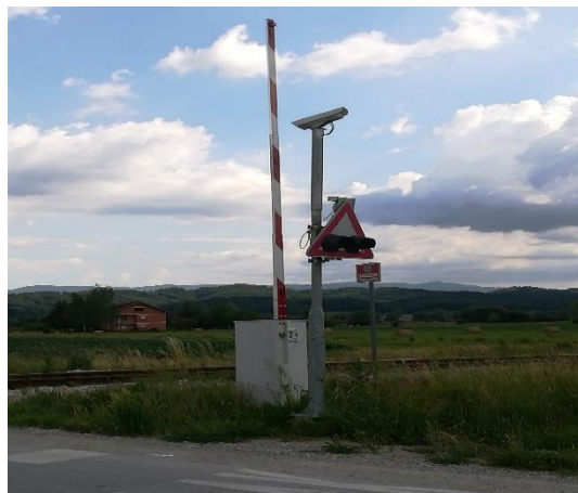
Slika 31. Polubranik na željezničko-cestovnom prijelazu Poznanovec
