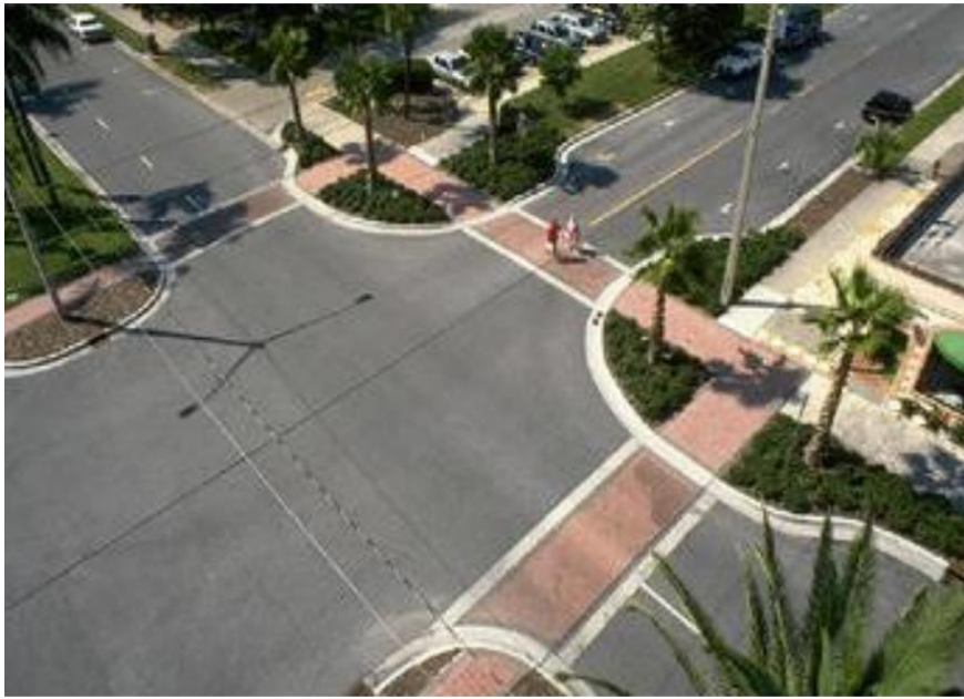
Slika 22: Primjer suženja vozne i proširenja pješačke površine
