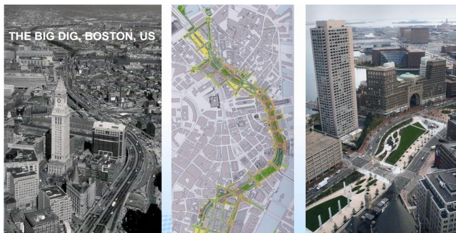
Slika 19: Big Dig, Boston; prije rekonstrukcije, projekt, poslije rekonstrukcije
