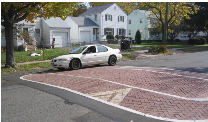
Slika 24: Izdignuće na kolniku izvedeno kombinacijom asfalta i betonskih elemenata
