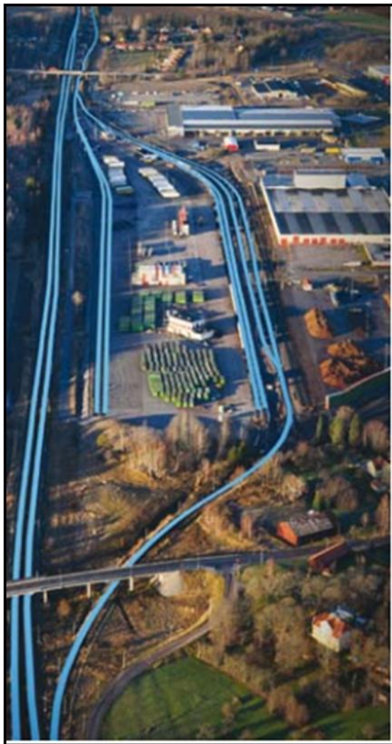
Slika 16. Prikaz Eskilstuna terminala
