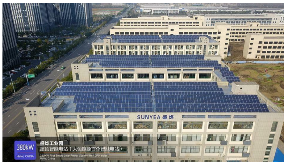
Slika 4. Solarni paneli na zgradama
