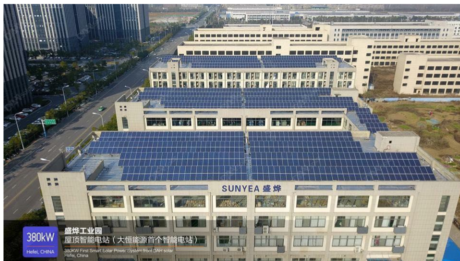
Slika 4. Solarni paneli na zgradama
