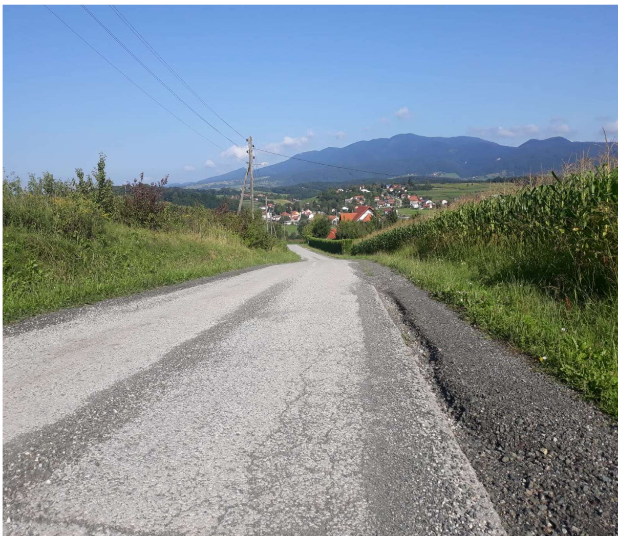
Slika 7. Prikaz dijela kolnika lokalne ceste LC 22067 u naselju Gornji Kraljevec
