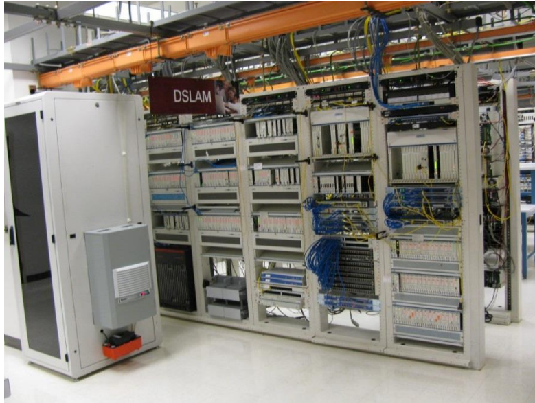
Slika 11. Prikaz DSLAM-a
