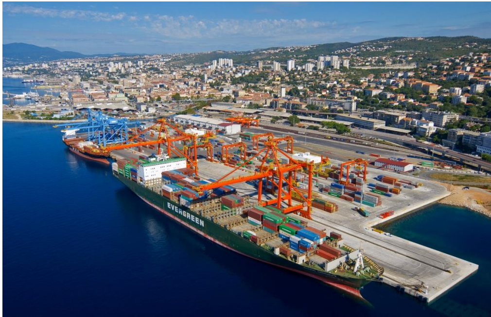
Slika 12. Kontejnerski terminal Jadranska vrata
