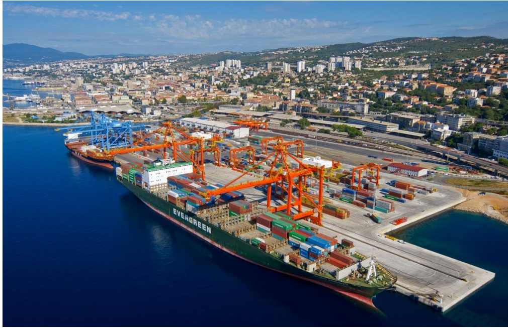
Slika 12. Kontejnerski terminal Jadranska vrata
