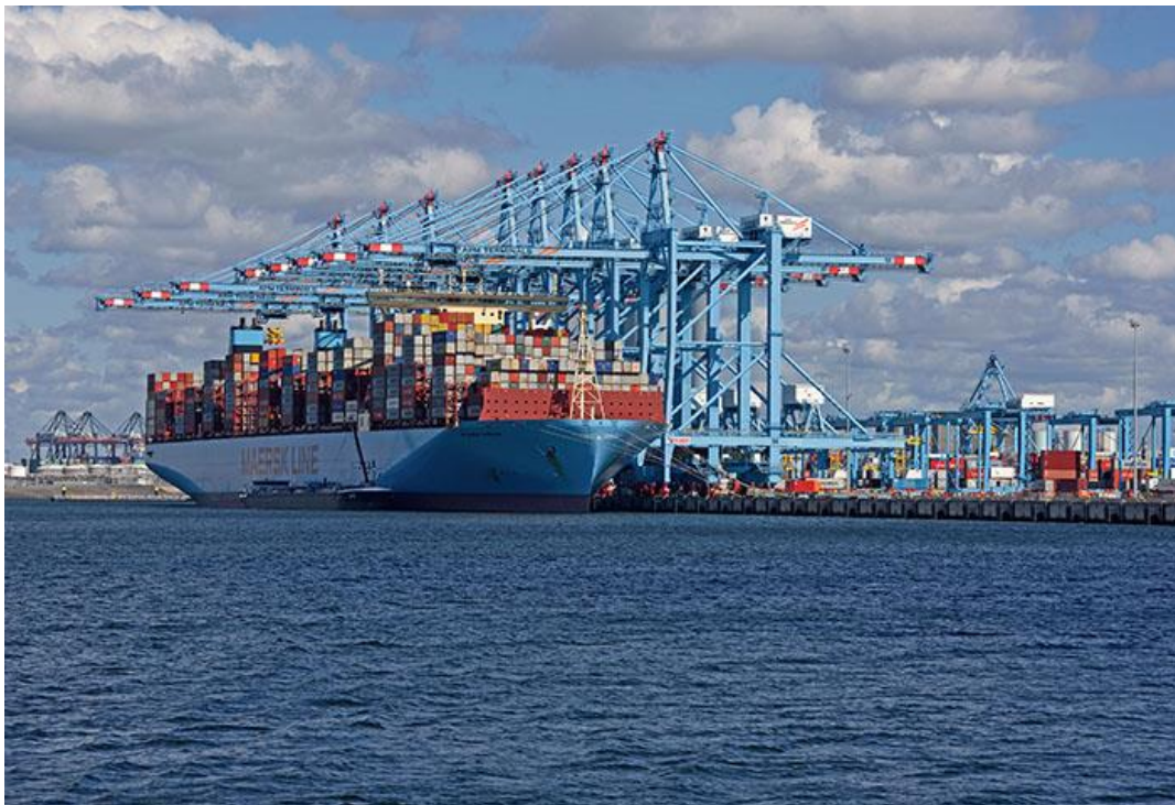
Slika 13. Post panamax dizalica na APM terminalu u luci Rotterdam
