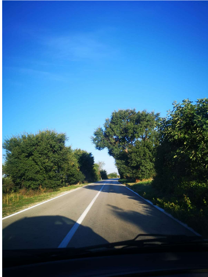
Slika 4. Neprilagođen slobodni profil
