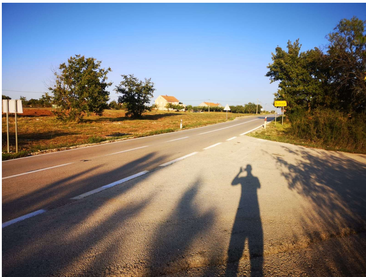
Slika 11. Prikaz stanja horizontalne signalizacije
