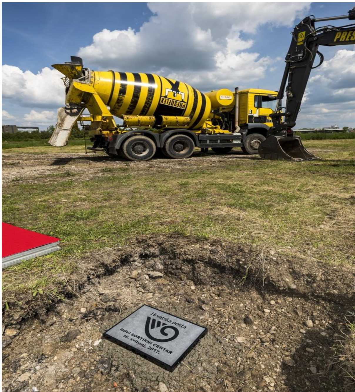
Slika 1: Kamen temeljac Novog sortirnog centra
