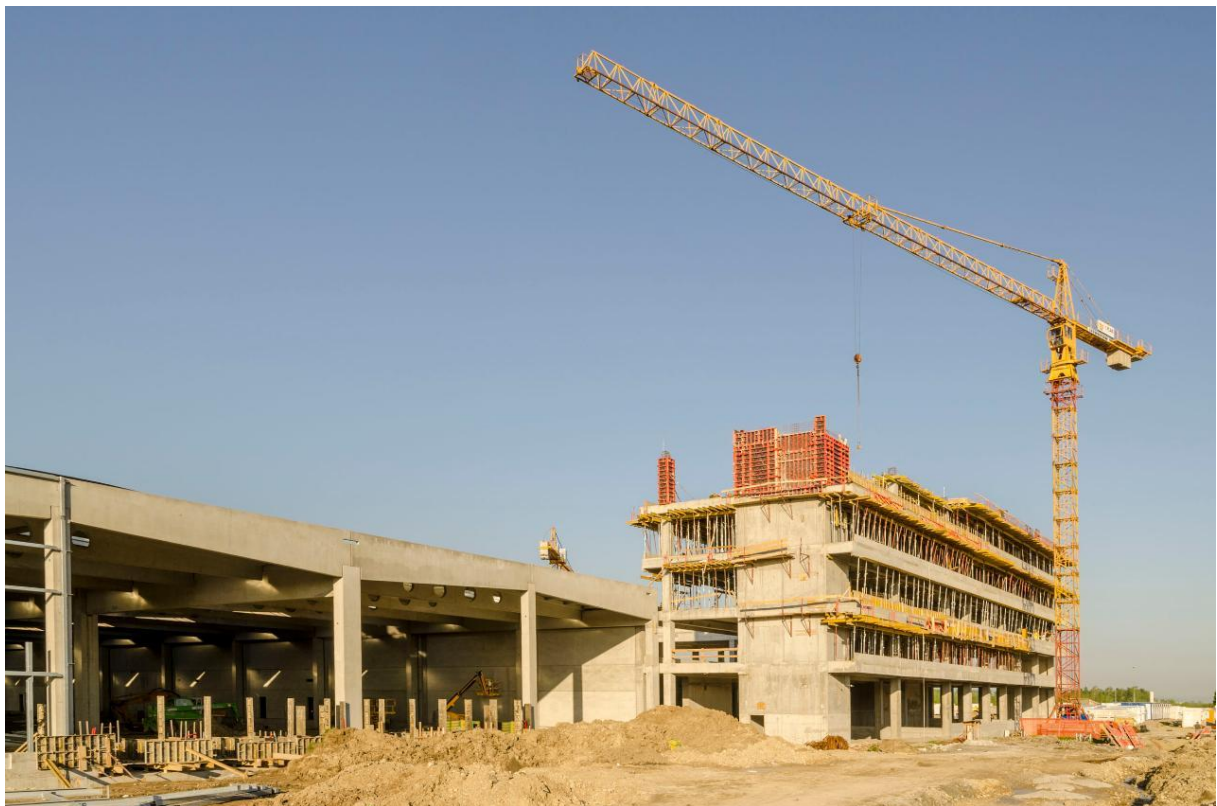
Slika 2: Izgradnja prve faze Novog sortirnog centra
