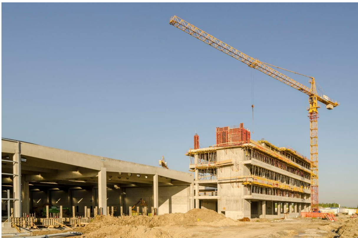
Slika 2: Izgradnja prve faze Novog sortirnog centra
