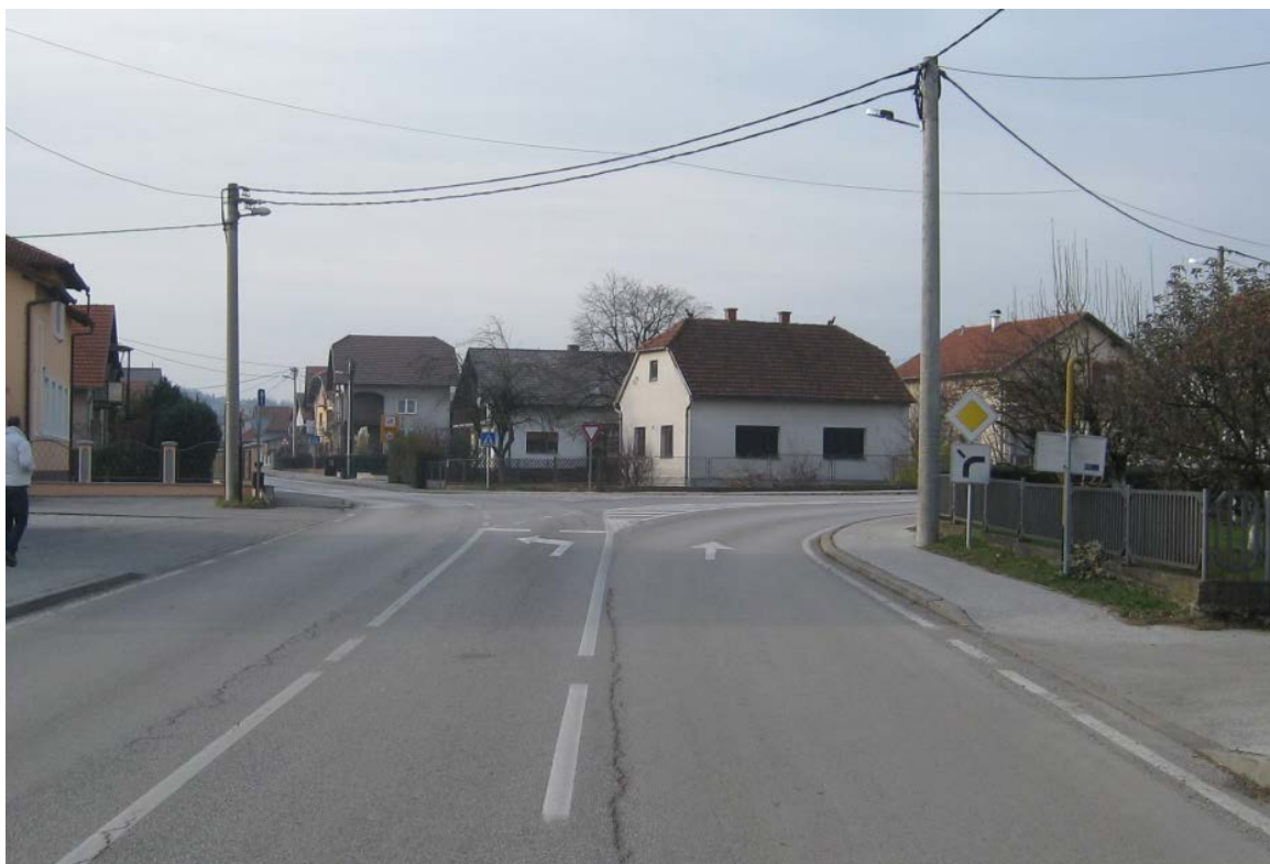
Slika 4: Prikaz predmetnog raskrižja – sjeveroistočni privoz [21]
