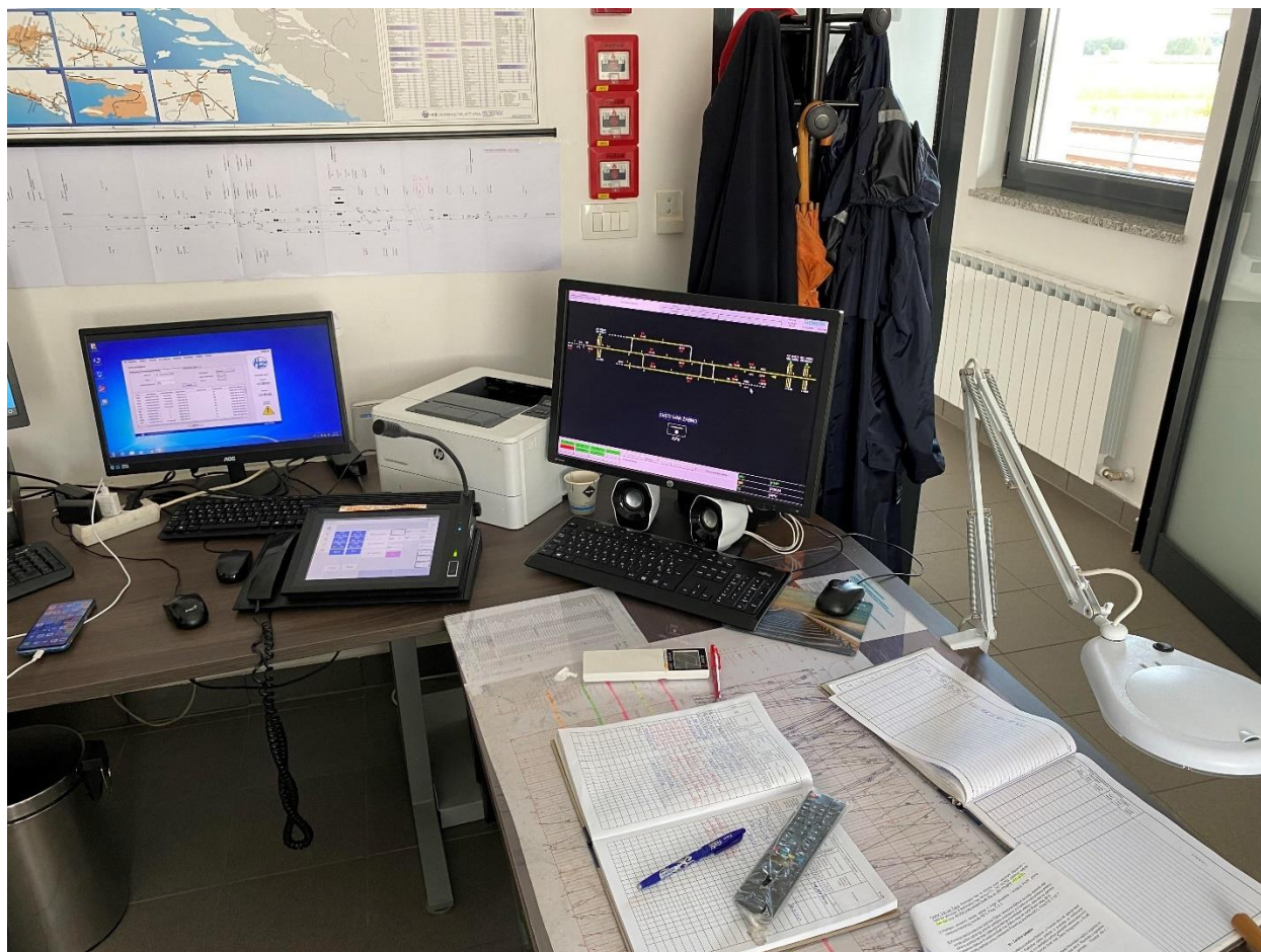
Slika 4. Postavnica elektroničkog ss uređaja
