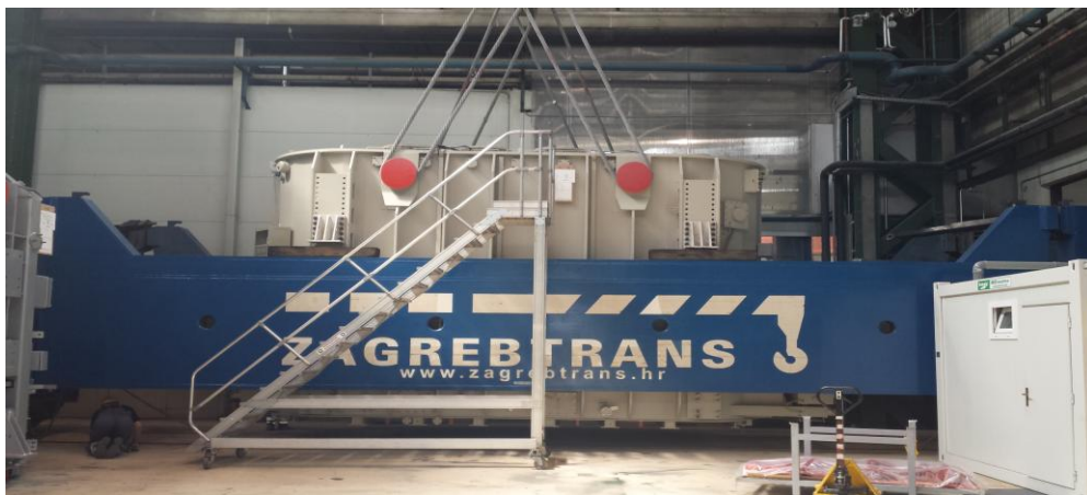
Slika 23. Ukrcaj transformatora Izvor: poduzeće ZAGREBTRANS
