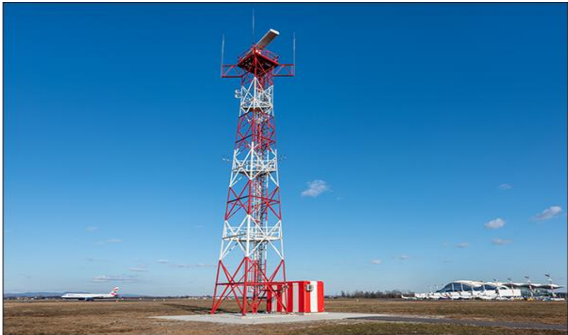
Slika 10. Prikaz novoinstalirane antene A-SMGCS-a na Zračnoj luci Zagreb. [14]
