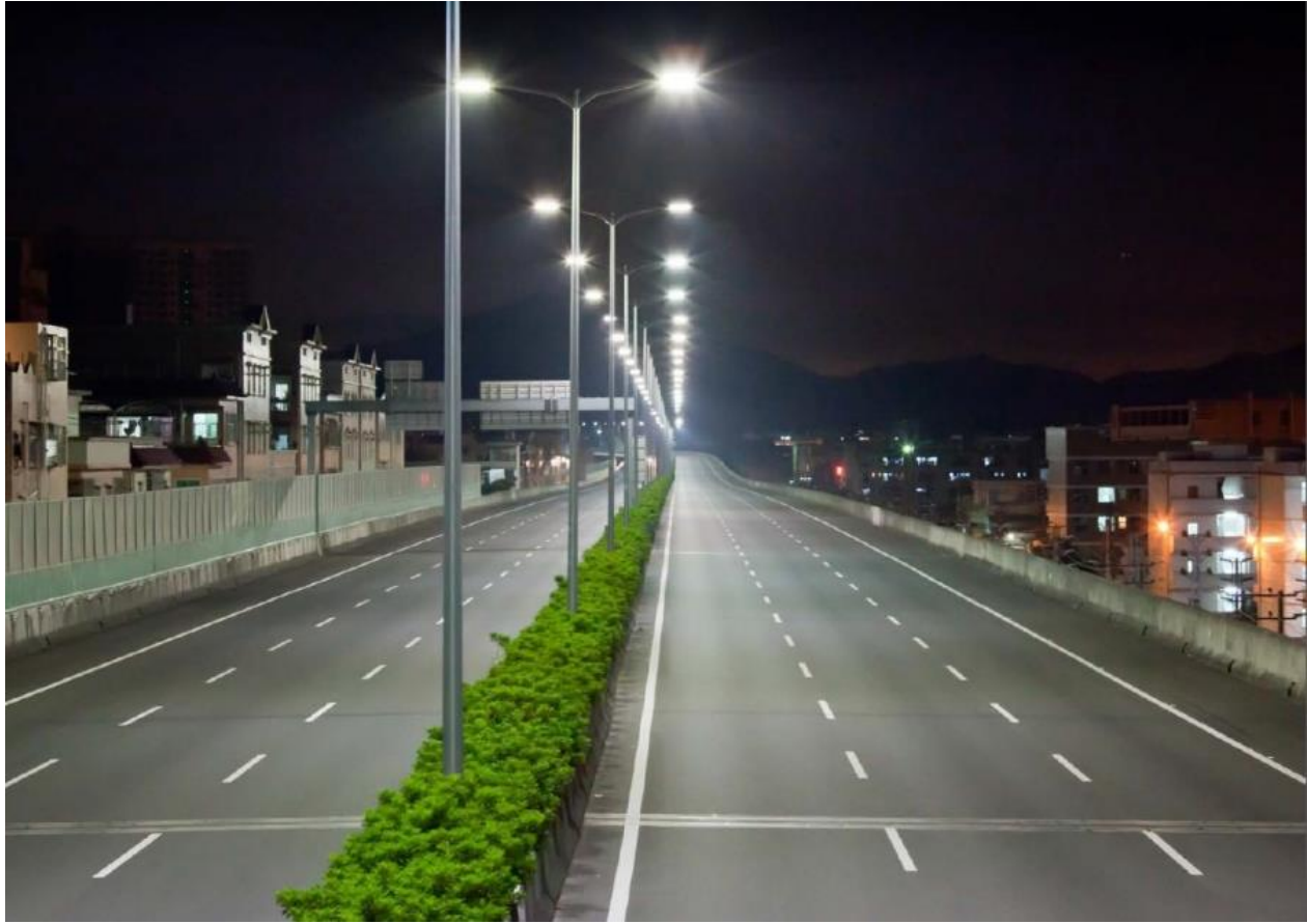
Slika 6: Centralni raspored izvora svjetlosti
