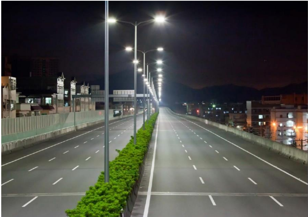
Slika 6: Centralni raspored izvora svjetlosti
