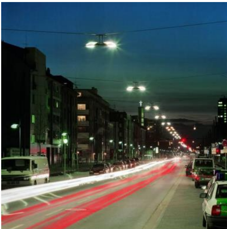
Slika 10: Aksijalni raspored izvora svjetlosti s nosivim žicama poprečno na cestu
