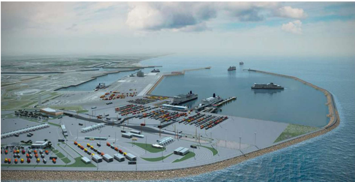
Slika 15. Port of Calais terminal (Calais, Francuska)
