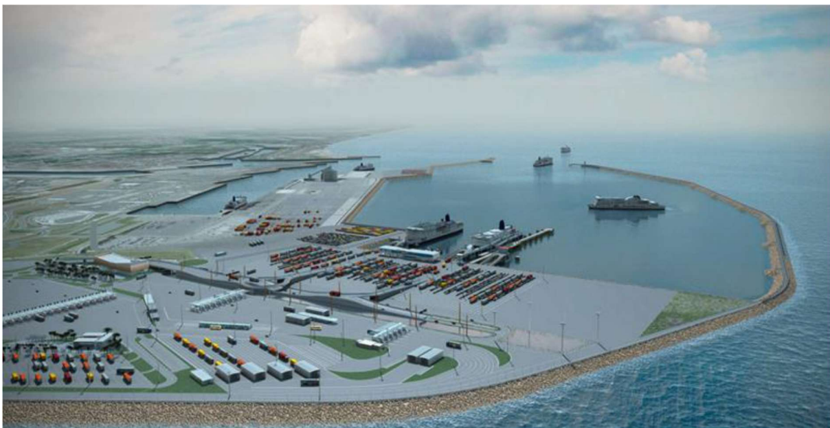
Slika 15. Port of Calais terminal (Calais, Francuska)
